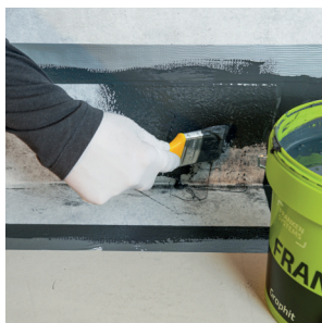
Application de la 2 e couche soit avec un pinceau...
