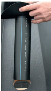
Steekstuk van de HWA in de opening plaatsen.
