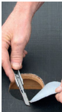
Snij met een scherp mesje de EPDM weg ter plaatse van de HWA opening.
