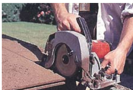
Foto links: op maat brengen van de Celit 4D plaat.
