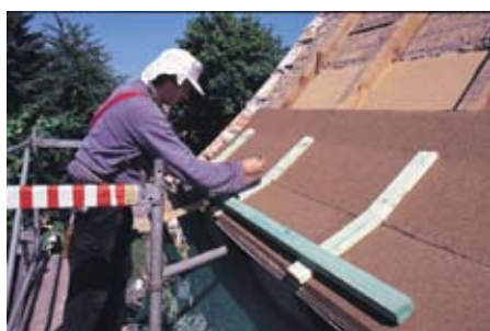
Foto links: Bij een kleine knik in de dakhelling onder aan het dakvlak dient de langse tand- en groefverbinding ter hoogte van deze knik te komen. Daartoe wordt de eerste rij platen op de gepaste breedte (afstand van de kop van de keperplanken tot de knik) gezaagd.
